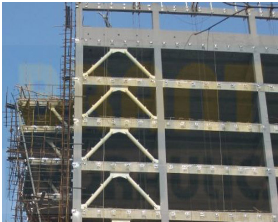
(b) Sistema de Disipación de Energía [41].
