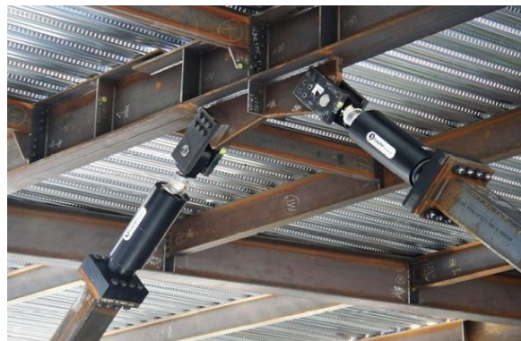
Figura 1.14: Contraventeo diagonal con AFVs [8].
