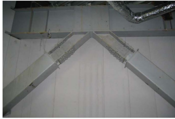
Figura 1.10: Contraviento de pandeo restringido (BRBs) [6].
