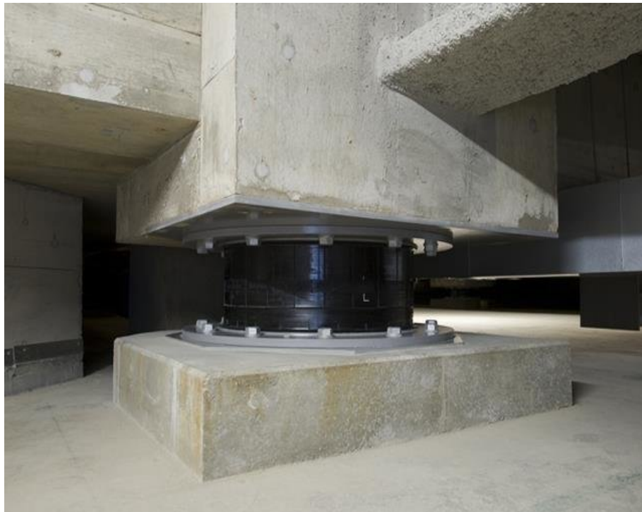
(a) Sistema de Aislamiento Sísmico [40].
